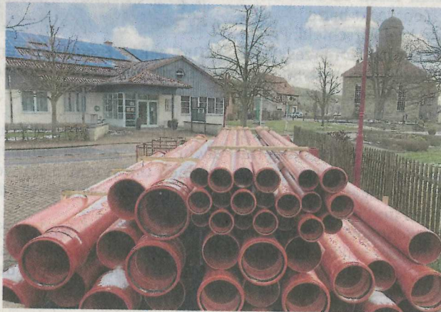
In Süß bisher keine Mangelware: Kunststoffrohre sind in dem Dorf auch an der Schieferstraße beim Bürgerhaus gestapelt. Die Arbeiten dort sind abgeschlossen.
