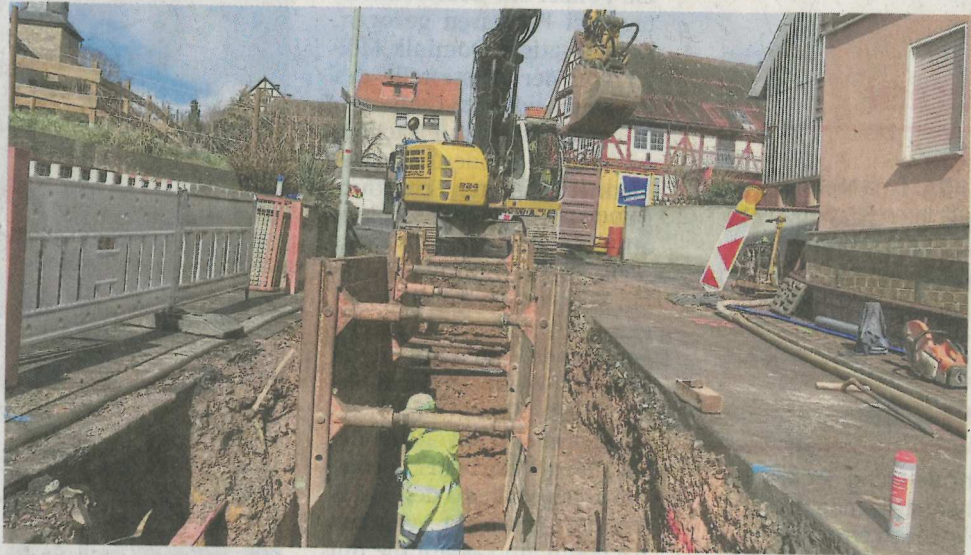
Die Bauarbeiten laufen zurzeit in der Weidenberggasse auf Hochtouren. FOTOS: RENÉ DUPONT
