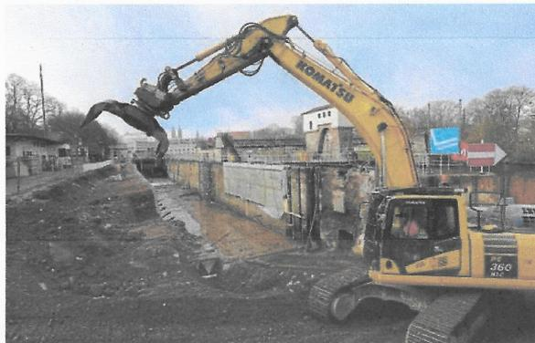
**Leere Schleusenammer:** Das Wasser wurde abgelassen, die Technik ausgebaut. Die neue Schleuse entsteht aus Stahlbeton.
